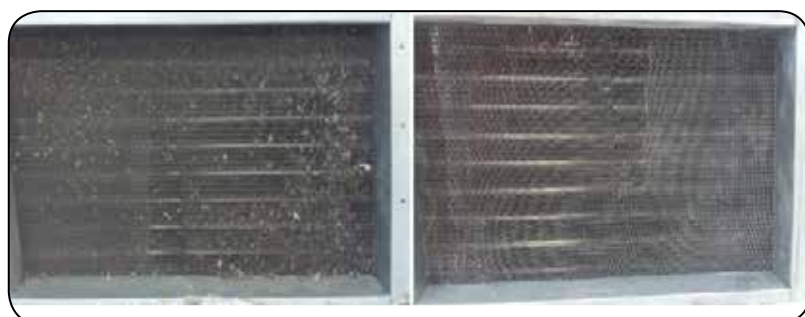
Avant (gauche) et après (droite) nettoyage à la vapeur
